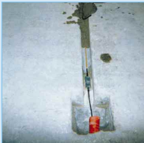
Corde optique scellée ultérieurement dans une saignée.
