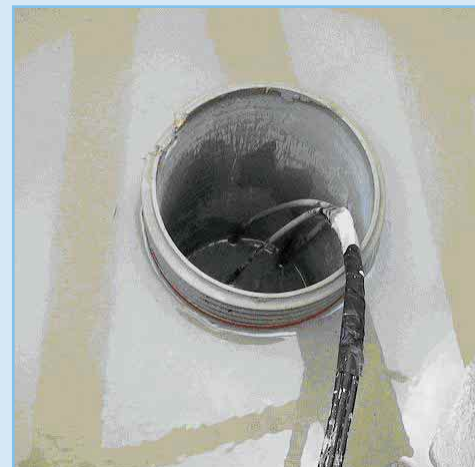
Corde optique dans un forage injecté.
