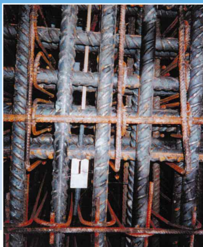
Corde optique dans une cage d'armature.
