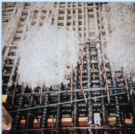
Corde optique pendant le bétonnage.
